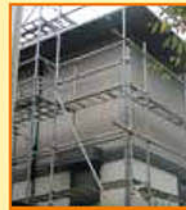
足場架設養生
