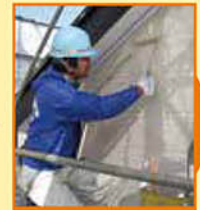
外壁の塗装 (下塗り・上塗り2回)
