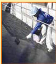
屋根の塗装 (下塗り・上塗り2回)
